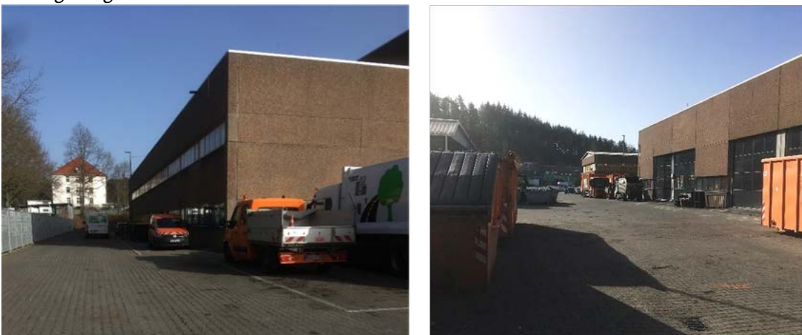
Abbildung 50: Fotos vom Betriebsgelände Stadtbildpflege Kaiserslautern
