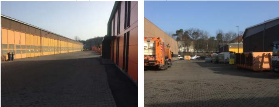
Abbildung 43: Fotos der Messachsen des Betriebsgeländes der Stadtbildpflege
